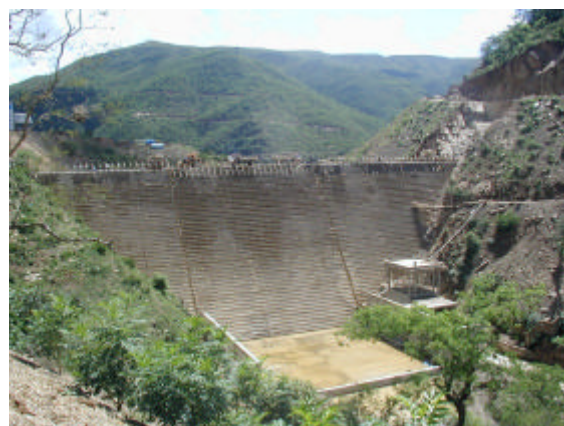
Presa "La Cañada"
