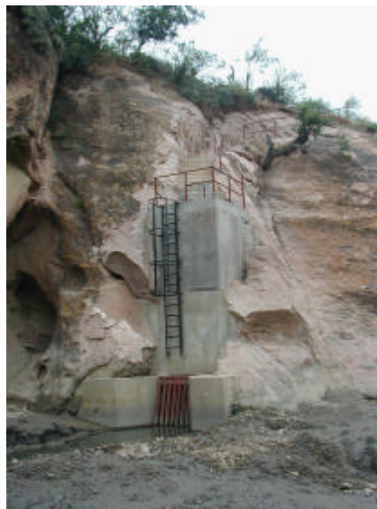
Bocatoma "Toro Muerto"
